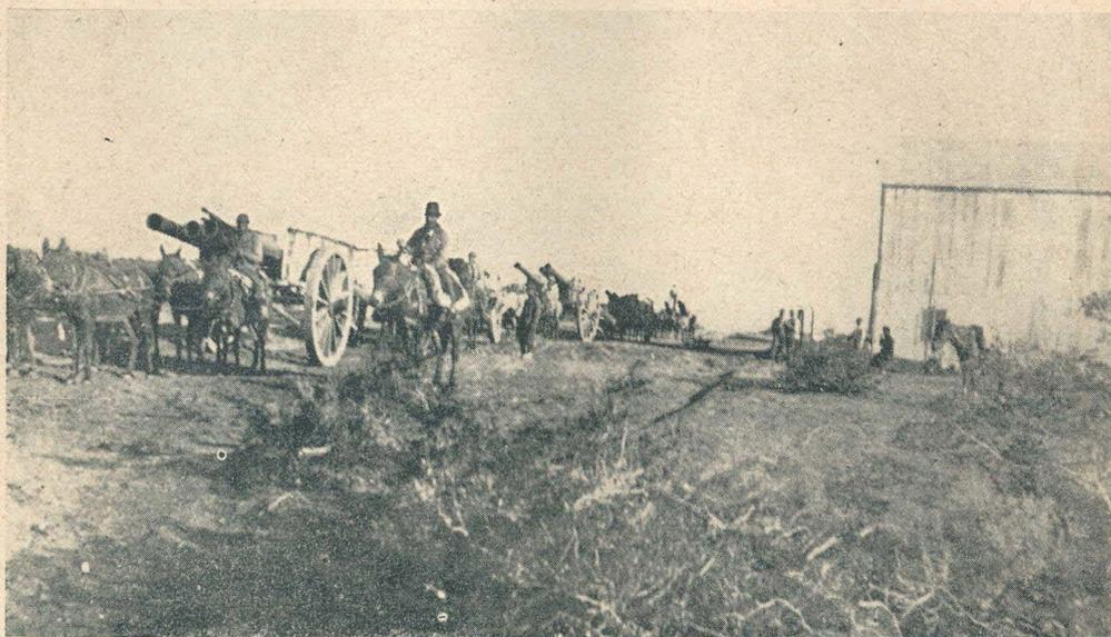
Fig. 2.—Transporte de cañería y materiales para la perforación N° 1 en Plaza Huincul.
